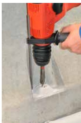
Obrázek 5b: Vrtání upevňovacích otvorů
