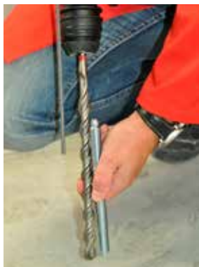
Obrázek 8b: Nastavení hloubky vrtání
