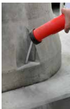
Obrázek 5c: Vyfoukání otvoru
