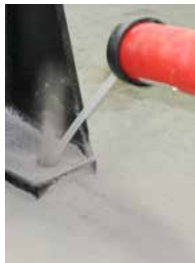
Obrázek 8c: Vyfoukání vyvrtaného otvoru
