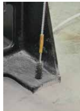
Obrázek 8d: Vyčištění vyvrtaného otvoru
