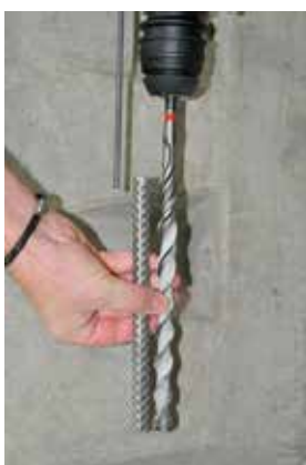
Obrázek 5a: Nastavení hloubky vrtání
