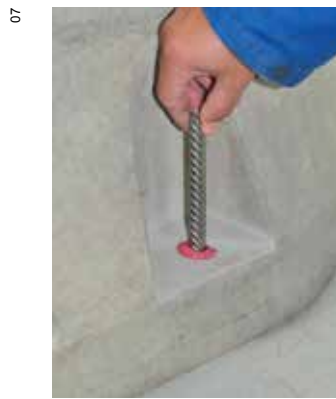
Obrázek 6b: Nasazení výztuže
