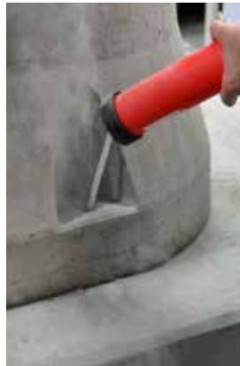
Kuva 5c: Puhalla reikä puhtaaksi
