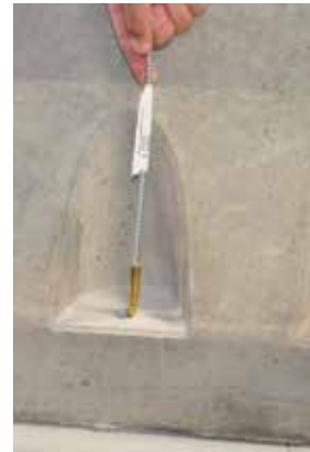
Kuva 5d: Harjaa reikä puhtaaksi
