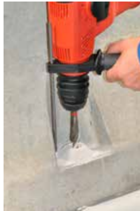
Kuva 5b: Poraa kiinnitysreiät
