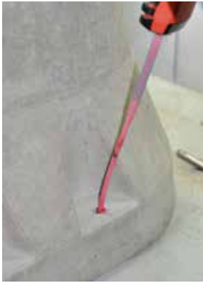
Kuva 6a: Täyttä injektiomassa
