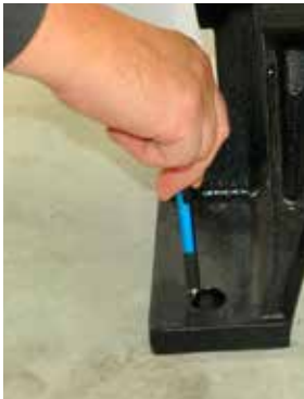
Kuva 8a: Merkkää porausreiät.
