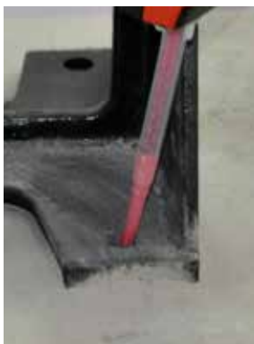
Kuva 9a: Täytä injektiomassa
