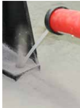
Kuva 8c: Puhalla reikä puhtaaksi
