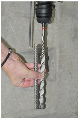
Figura 5a: Impostare la profondità di perforazione.
