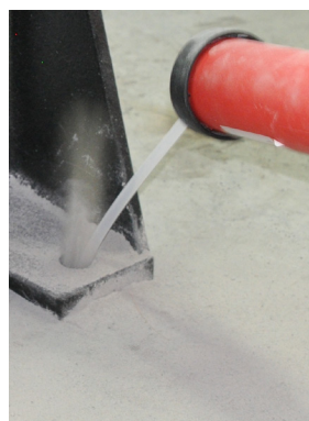
Figura 8c: Soffiare aria nel foro.
