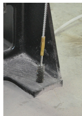
Figura 8d: Pulire il foro.
