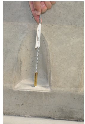
Figura 5d: Spazzolare il foro.
