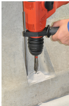
Figura 5b: Realizzare i fori di fissaggio.
