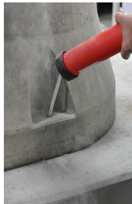
Figura 5c: Pulire il foro soffiando aria.
