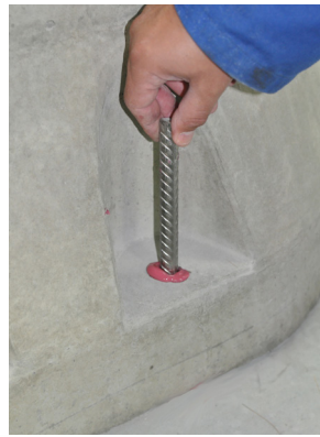
Figura 6b: Inserire l'armatura
