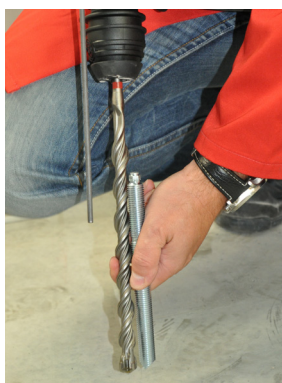
Figura 8b: Impostare la profondità di perforazione.
