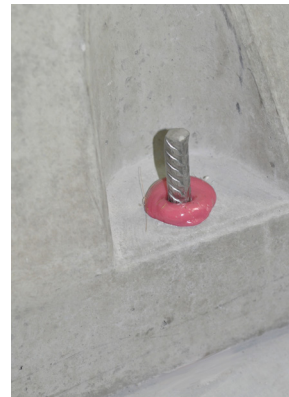
Figura 6b: Inserire l'armatura
