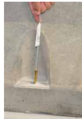
Afb. 5d Boring uitborstelen
