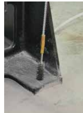
Afb. 8d Boorgat schoonmaken
