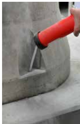
Afb. 5c Boring uitblazen
