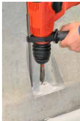
Afb. 5b Bevestigingsgaten boren
